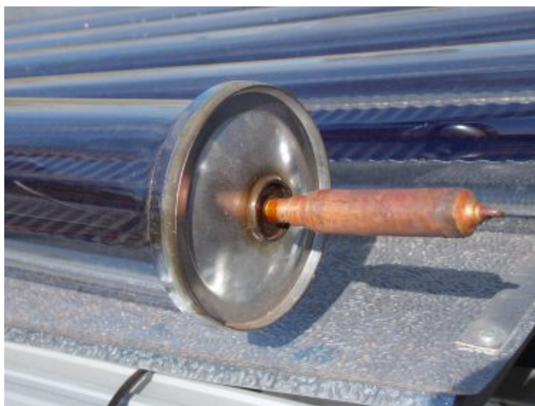
Figura A4: Detalhe do condensador do tubo de calor (Heat Pipe) do tubo à vácuo.
