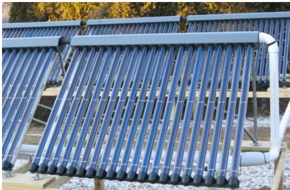
Figura 7: Coletores evacuados com espaçamento entre os tubos. Fonte: Radiant Solar, Inc.
