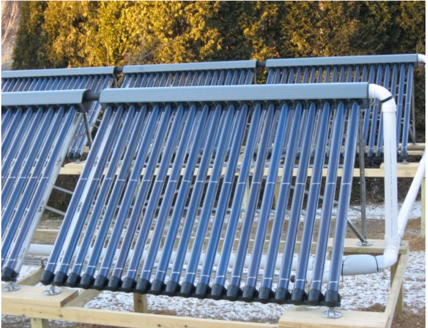
Figura 1: Coletores evacuados com espaçamento entre os tubos. Fonte: Radiant Solar, Inc.
